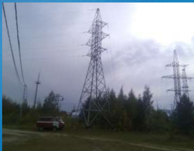
Нарушение энергоснабжения (описание)
